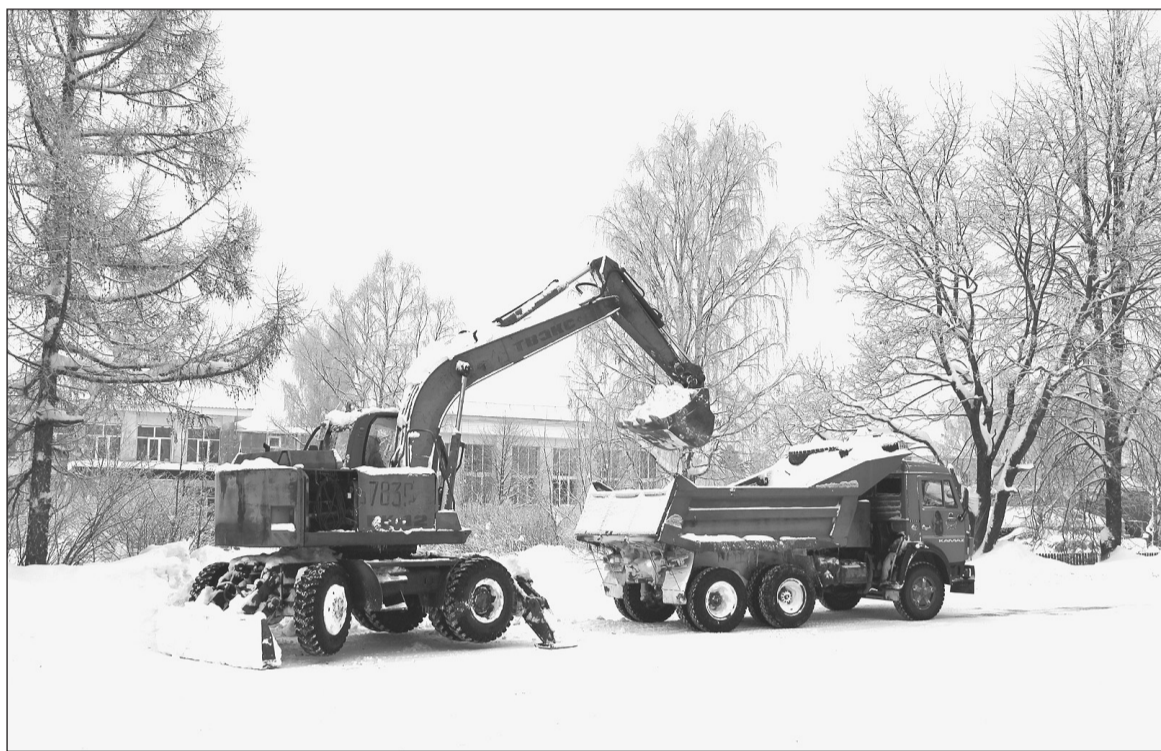
На вывозке снега с перекрестков и пешеходных переходов были задействованы три самосвала КАМАЗ и экскаватор.
